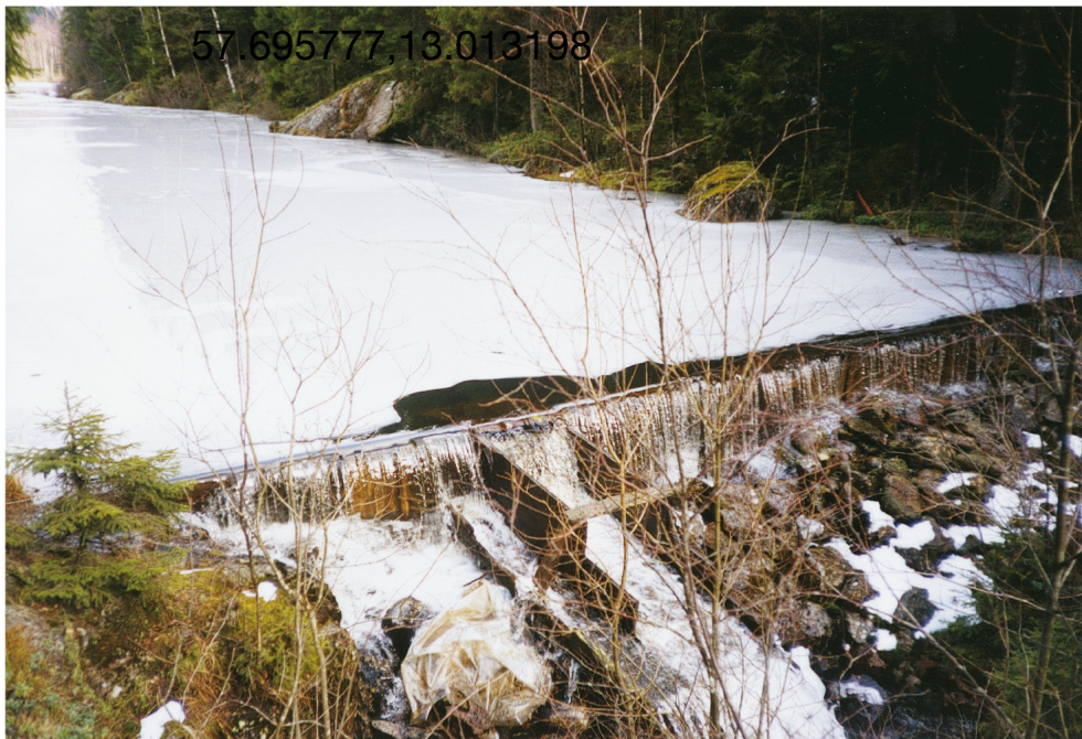
Dammluckan vid den anlagda sjön.
